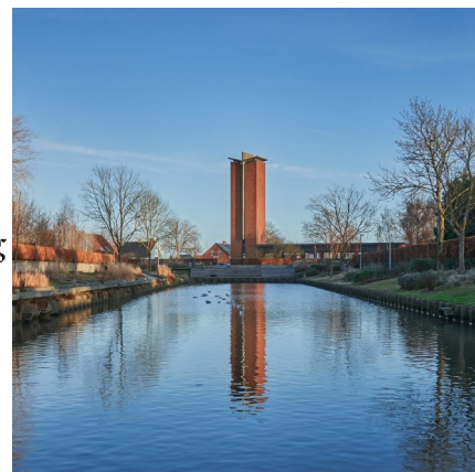
Rønnevang Kirke fra 1976 spejler sig smukt i regnvandsbassinet.
